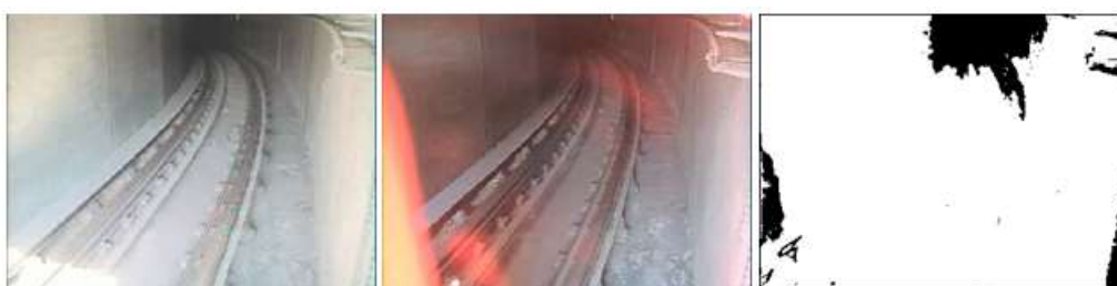
Figure 46 : exemple de variation lumineuse sur une émergence d'un métro. Sur les deux images successives d'une même séquence, nous pouvons remarquer un changement brusque de la luminosité provoquée par l'entrée du train dans le tunnel. A droite, le masque de mouvement associé est pratiquement saturé.
